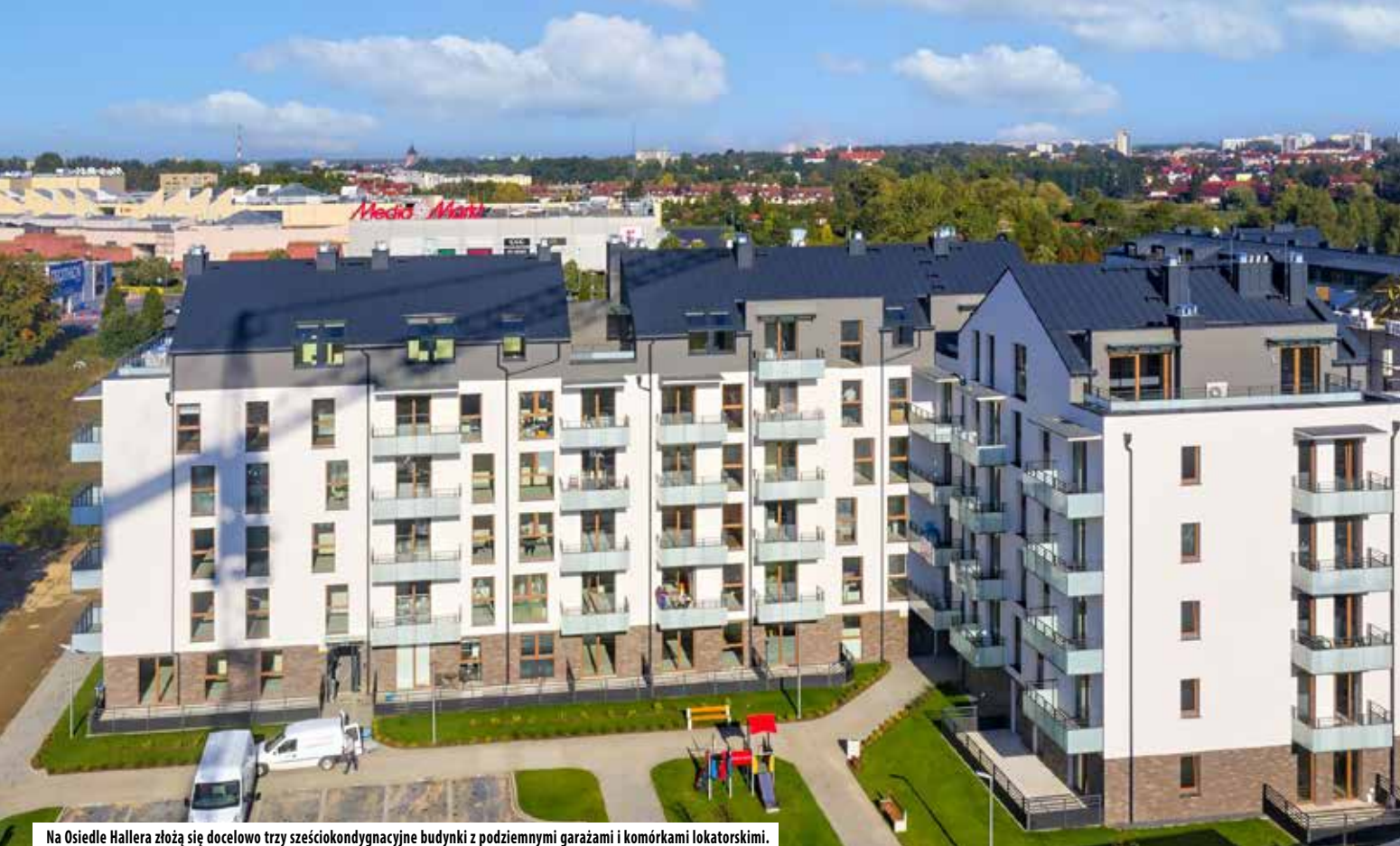
Na Osiedle Hallera złożą się docelowo trzy sześciokondygnacyjne budynki z podziemnymi garażami i komórkami lokatorskimi.
